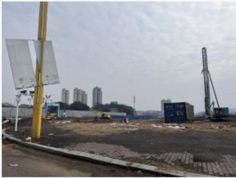
已建临时拦挡措施
